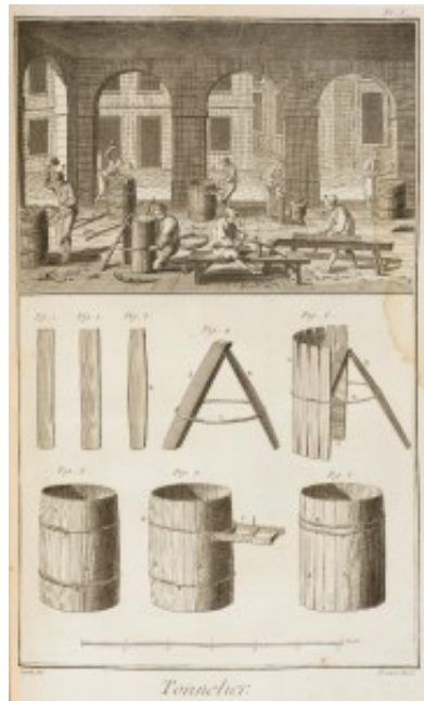
Figure 7: Coopers shaping staves and assembling casks. “Tonnelier,” Plate 1. Recueil de planches sur les sciences, les arts liberaux, et les arts mechaniques : avec leur explication . Paris: Chez Briasson : David : Le Breton : Durand, 1762- 1772. Courtesy of the Winterthur Library: Printed Book and Periodical Collection, Winterthur, DE.
